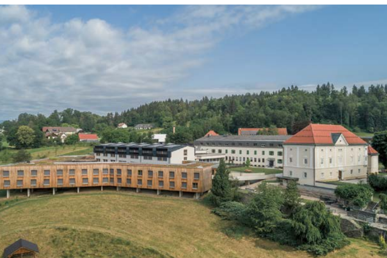
Die HBLA Pitzelstätten feierte im Beisein von BM Norbert Totschnig am 1. Juli 2024 ihren 70. Geburtstag. Zu diesem Anlass wurde auch der Spatenstich für das neue naturwissenschaftliche Zentrum vorgenommen.
